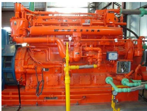
Montaje de Moto-Generadores Waukesha Planta Pichanal (TGN S.A.)
