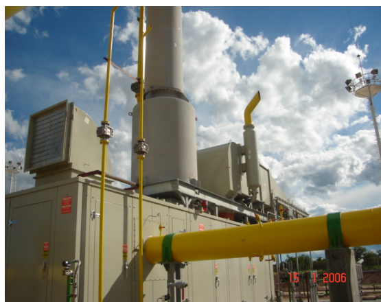
Montaje y Puesta en Marcha de Turbo-Compresor Solar Taurus 60- PTAS Deán Funes y Lavalle (TGN S.A.)
